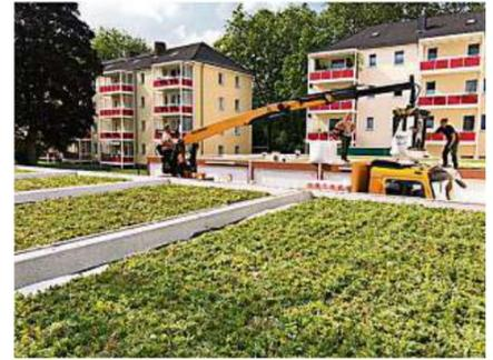
aus einer Kassette mit Wasserspeichern, die bis zu 35 Liter an Regenwasser aufnehmen können. Bei Starkregen wird auf diese Weise die Kanalisation entlastet. Das Wasser in den Speichern wird durch Verdunstung dem natürlichen Kreislauf wieder zugeführt und kühlt dabei die Luft in der Umgebung. Der restliche Niederschlag wird erst nach einer zeitlichen Verzögerung von der Dachfläche abgeleitet.
