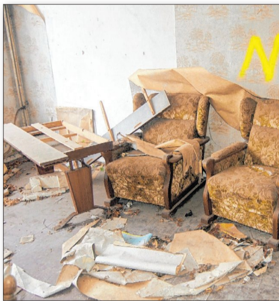
Ende der 80er Jahre ist für das Gebäude Schicht im Schicht. Die Stadt ordnet eine Zwangsäumung an, die Immobilie ist nicht mehr sicher.
